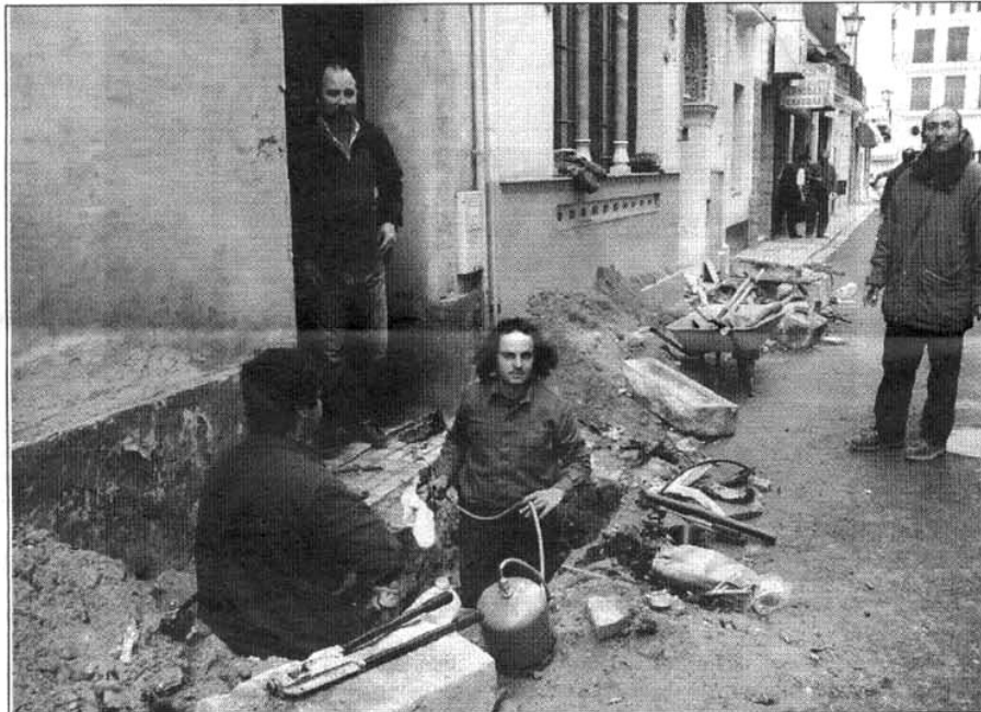
Dos operarios de Sevilla arreglando en una zanja una de las averías que causó un apagón. / FERNANDO RUSO
